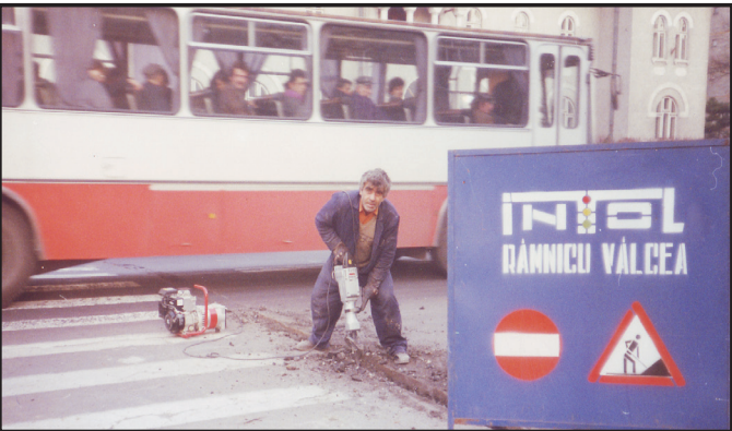
Intol Rm Vâlcea, 1996, a aplicat în lucrările de semaforizare ale Petroșaniului, tehnologia de subtraversare cu cabluri a străzilor fără întreruperea circulației!
